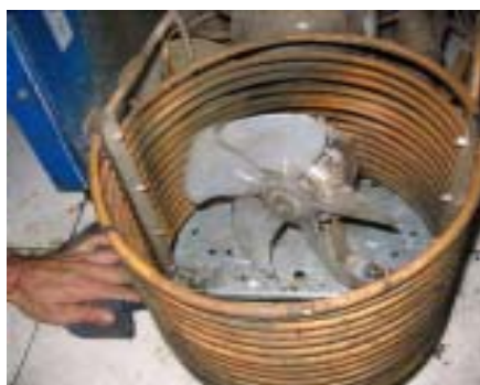
Foto 20 - Vista superior com o aspecto final do condensador do expositor vertical após a limpeza.
