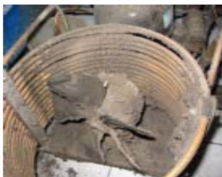
Foto 19 - Vista superior mostrando aspecto do condensador do expositor vertical antes da limpeza.
