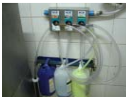
Figura 34 - Diluidor para os Produtos usados para desinfecção das instalações, equipamentos e utensílios.
