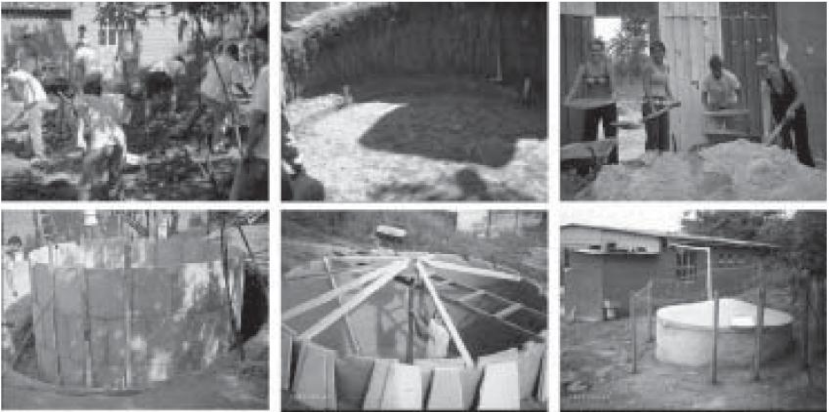
Figura 7.2 - Algumas etapas da construção de cisternas de placas destinadas ao armazenamento de água de chuva: início da escavação, escavação concluída, peneiramento da areia para confecção das placas, colocação das placas, colocação das vigas da cobertura e cisterna pronta
