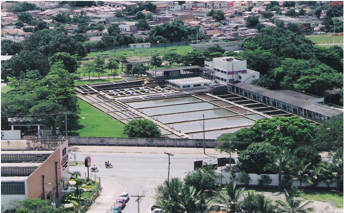
Figura 45 – Vista geral da estação de tratamento do sistema João Leite em Goiânia, em dezembro / 2003
