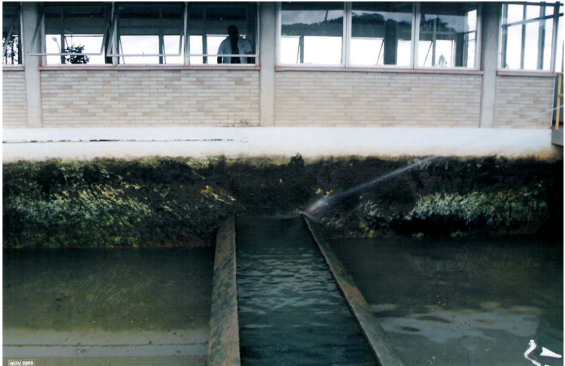
Figura 63 – Início do processo de lavagem de uma das células do filtro
